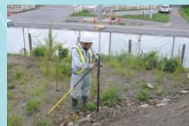
RTKを使用した細部測量
