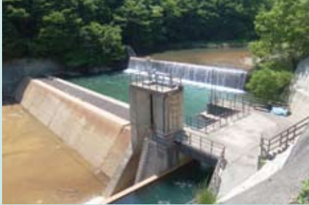
砂防施設点検
