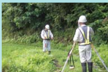
電子平板を利用した細部測量
