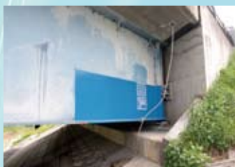
橋梁補修設計 (桁端防錆)
