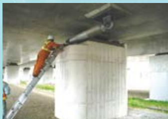
国道13号 (緊急橋梁点検)
