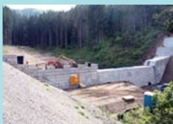
砂防ダム設計 (米沢市)
