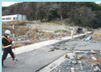
石巻市 (津波浸水被害)
