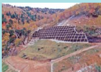
斜面安定対策 (米沢市)
