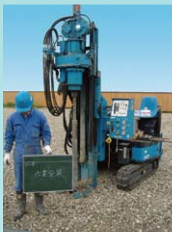
環境調査用ボーリングマシン
