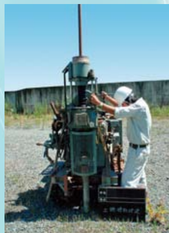
ロータリーボーリングによる土壌採取
