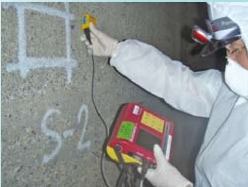
非破壊鉄筋調査（電磁誘導法）
